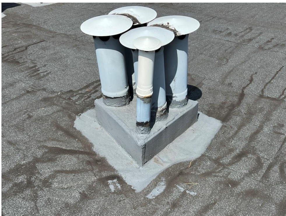
Zdj. 2. Przykładowe kominki wentylacyjne do przebudowy
